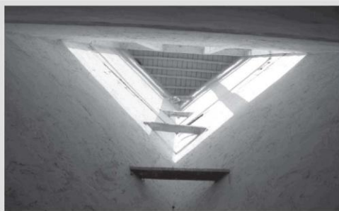
تصویر ۱۳: بست‌های چوبی در اتصال پره‌های بادگیر با فواصل کمتر
